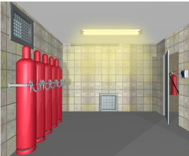
Abb. 34 Lagerung von Flüssiggasflaschen im Lagerraum
